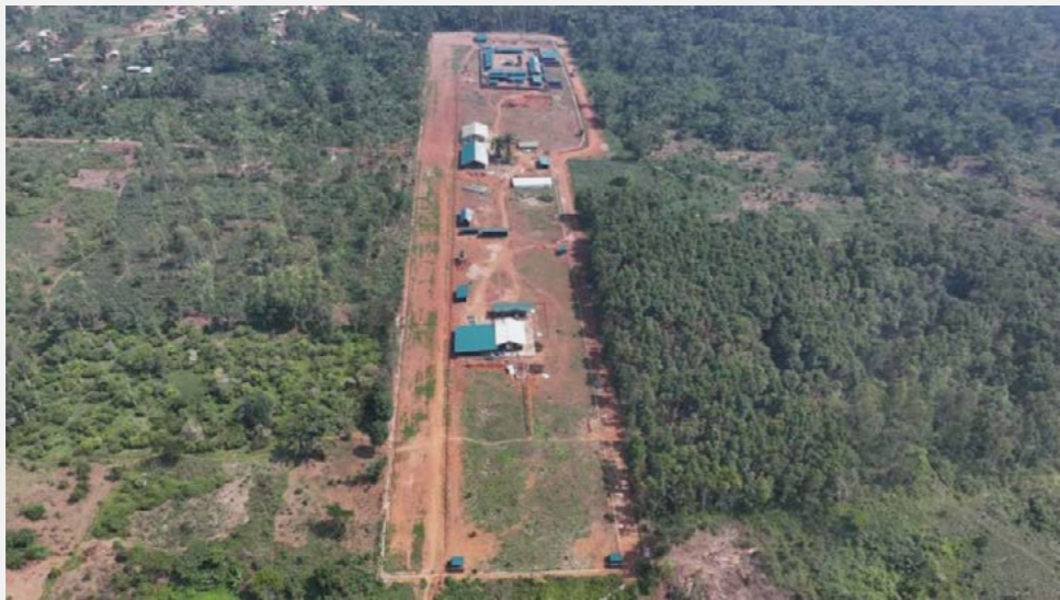
Fig 7 : Exemple de pôle industriel à Mangina
